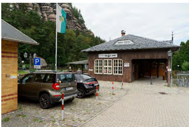
Bahnhofsgebäude Oybin, reservierte Stellplätze
