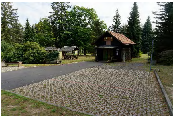
Blockhütte mit Stellplätzen (Rasengitter)
