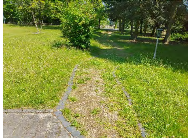
vergrasende Wege, defekte Gartenleuchte
