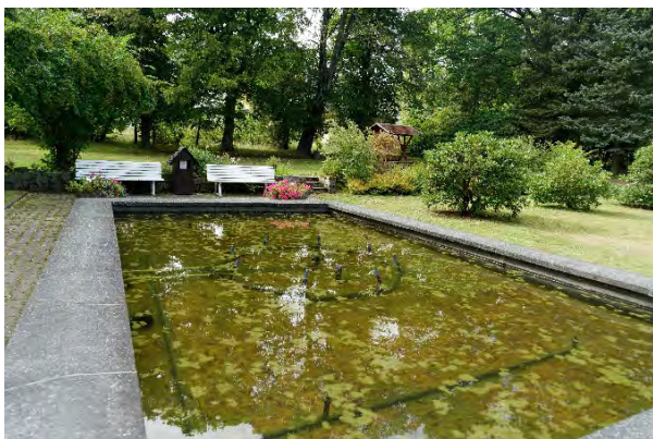
Wasserbecken mit Springbrunnenanlage
