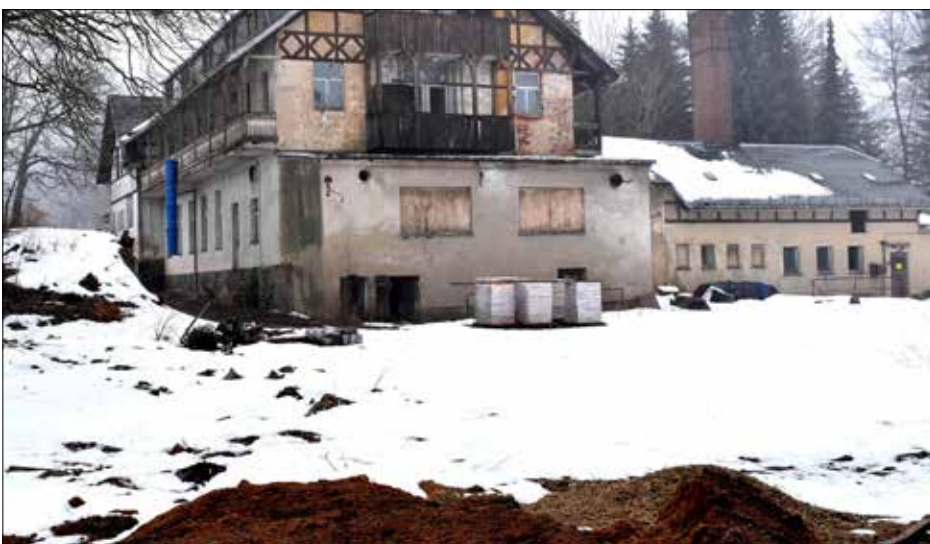
Der Hof ist geräumt, die Garagen die sich links im Bild befanden wurden abgerissen
