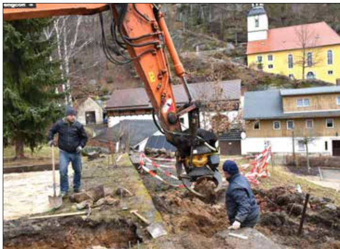
Sebastian Sonsalla, Torsten Buttig und im Bagger der Mitarbeiter der OSTEg Bernd Herfort bei vorbereitenden Drainagearbeiten.
