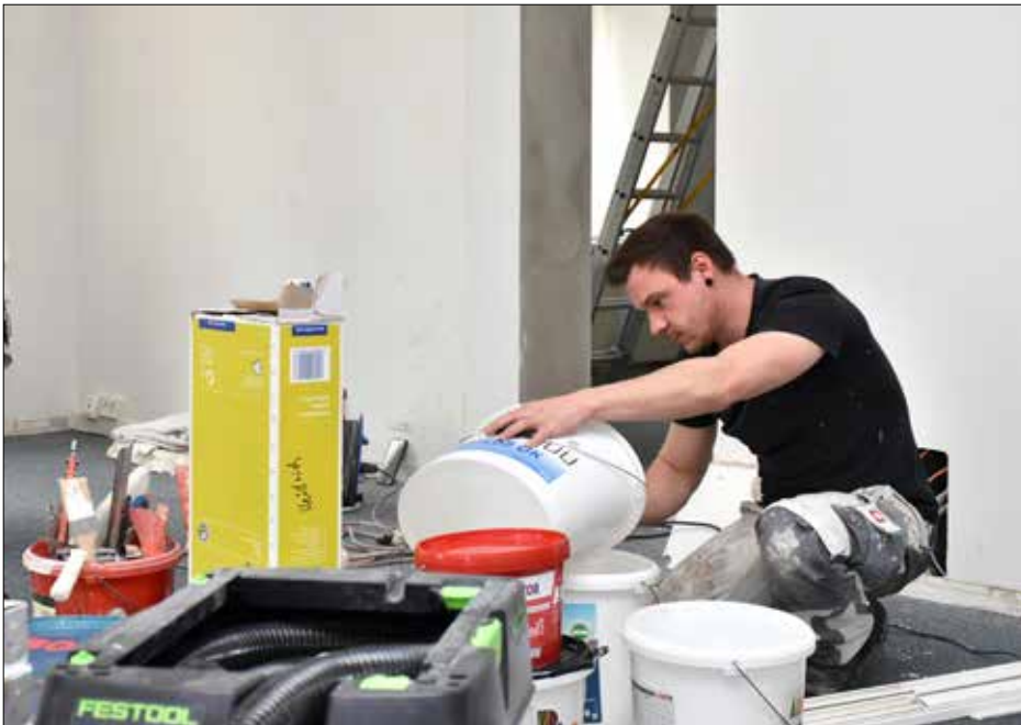
Ein Mitarbeiter der Malerfirma Heidrich aus Hainewalde bei der Arbeit
