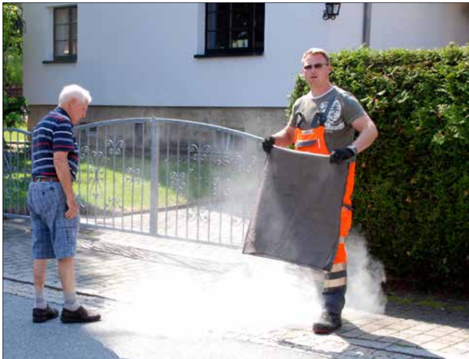
Die Abwasserkanäle wurden sowohl in Lückendorf als auch in Oybin benebelt, um Schwachstellen lokalisieren zu können.
