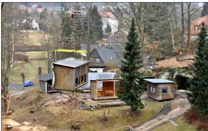
Das Häuschen mit der Technik schwebt herein.
