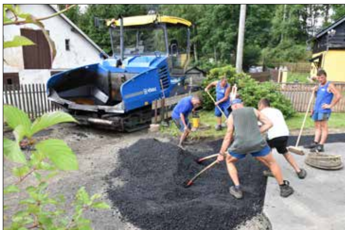
Die Grundstückseinfahrten galt es per Hand zu asphaltieren.
