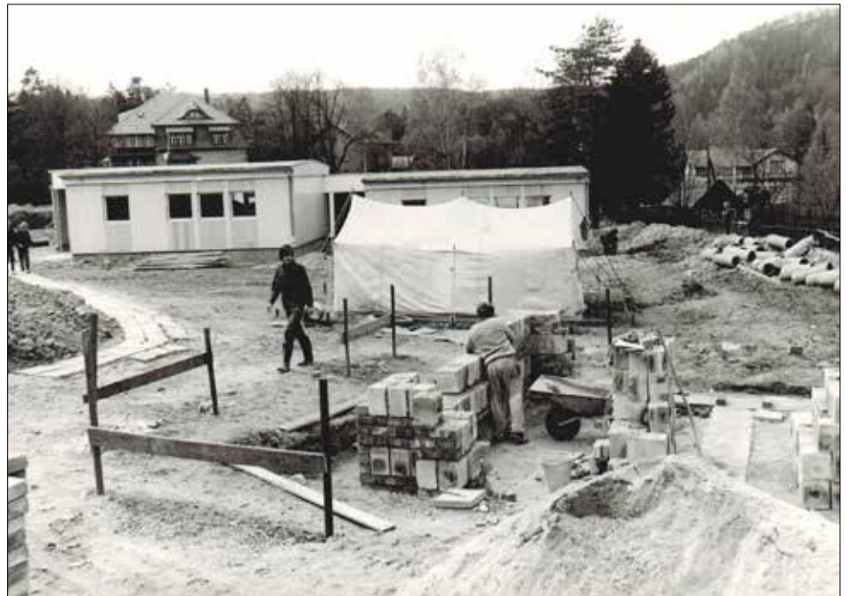
Im Bau befinden sich die neuen Bungalows.
