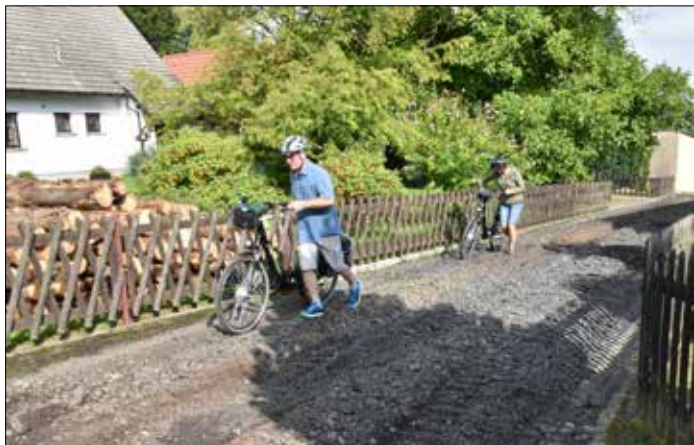
Nach den Fräsarbeiten war ein Durchkommen schwierig.
