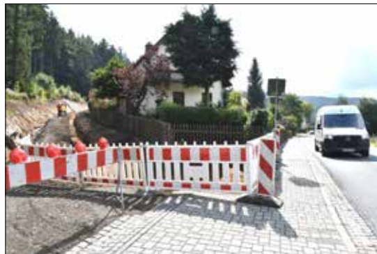
Am Abzweig zum Töpfer wurde bereits Baufreiheit geschaffen.
