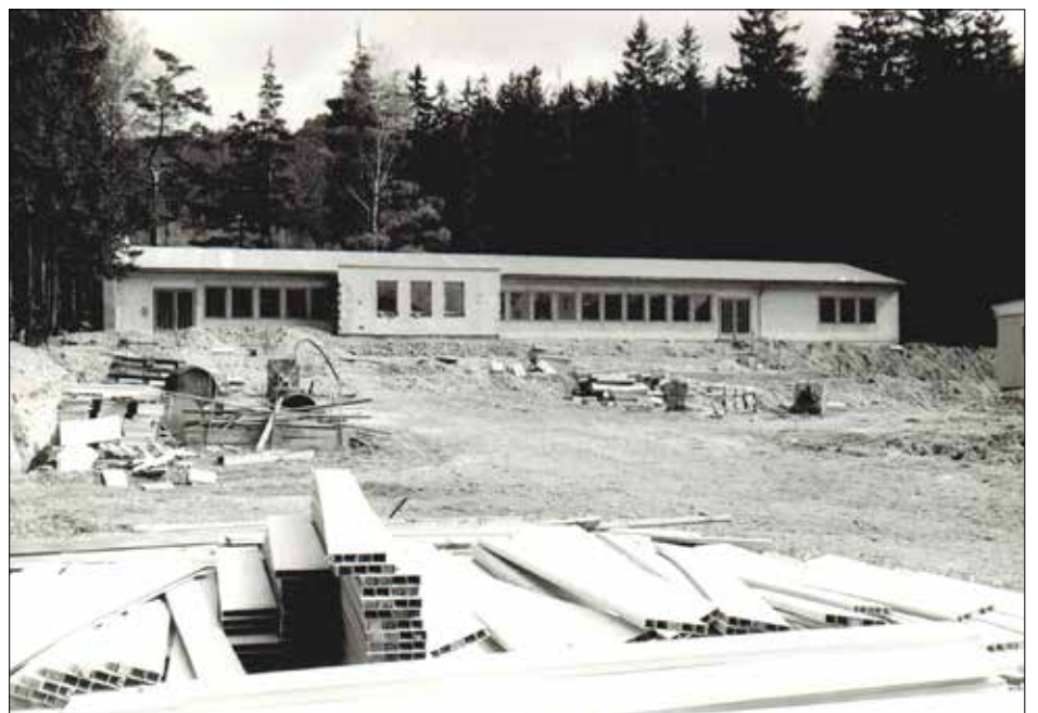
Das Mehrzweckgebäude, davor Bauelemente der Bungalows.
