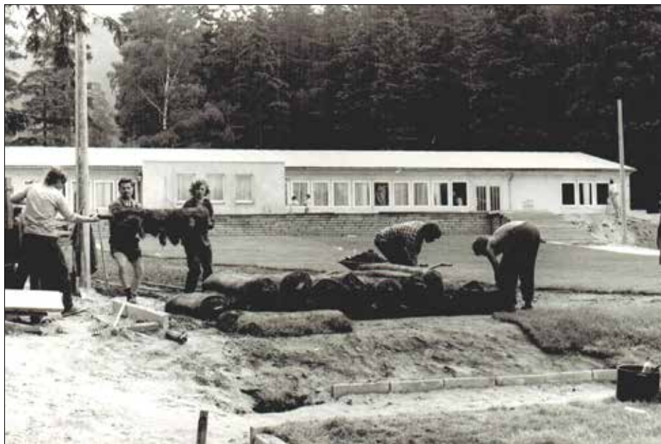
Auslegen von Rollrasen der eine intensive Pflege benötigt.
