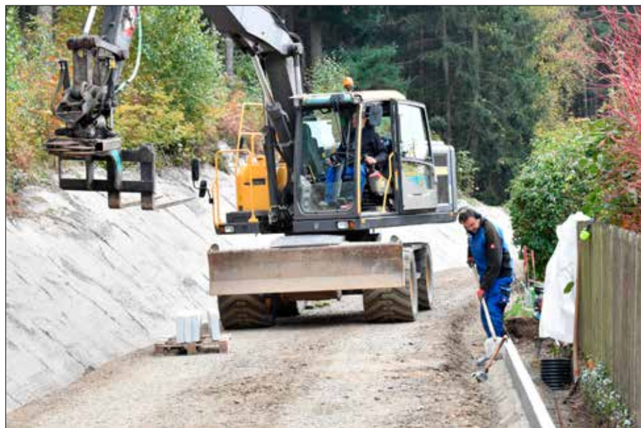
Vor dem Asphalt gilt es die Borde zu setzen.
