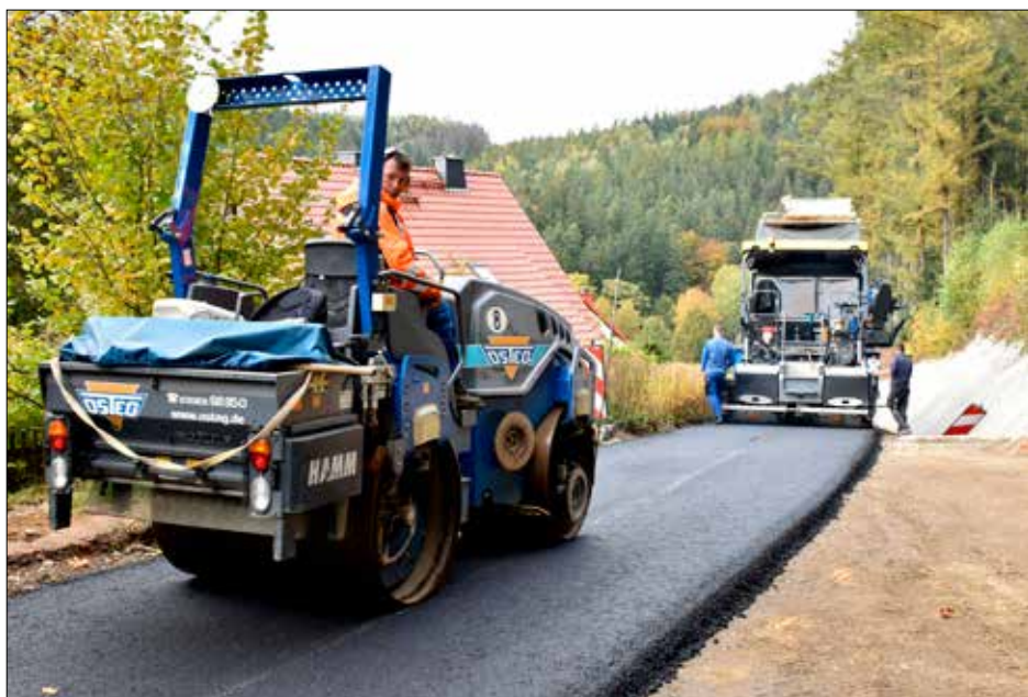
Eine neue Asphaltsschicht erhielt die Zufahrtsstraße im vergangenen Monat.
