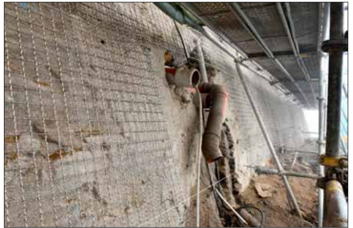
Ein Kleid aus Eisen garantiert die Stabilität der Fundamente.
