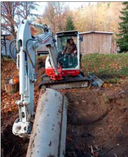
Ein erster Teich wird ausgehoben. Foto S. Sonsalla
