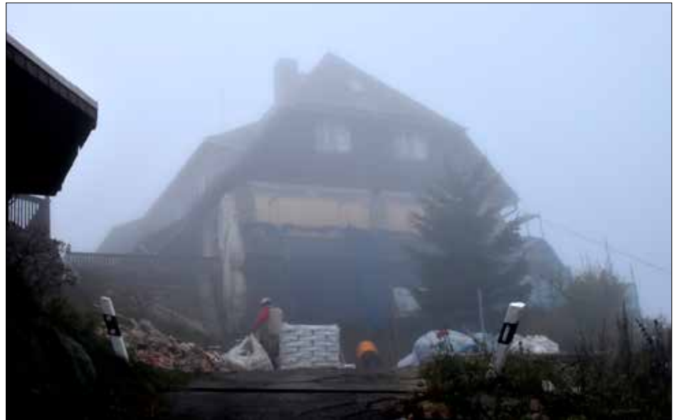
Trotz des starken Nebels gehen die Arbeiten voran.
