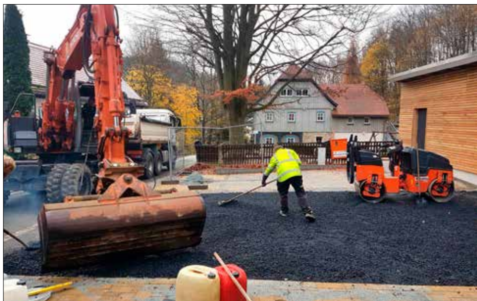
Nach den Pflasterarbeiten erhielt die Zufahrt zum Wanderrastplatz eine Asphaltschicht. Foto I. Stephan
