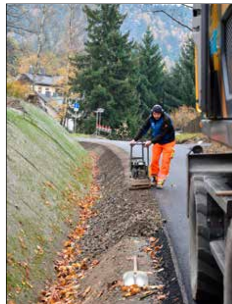
Die Bankettsanierung ging mit dem Straßenbau einher. Bankette dienen als Sicherheitsstreifen für die Verkehrsteilnehmer.
