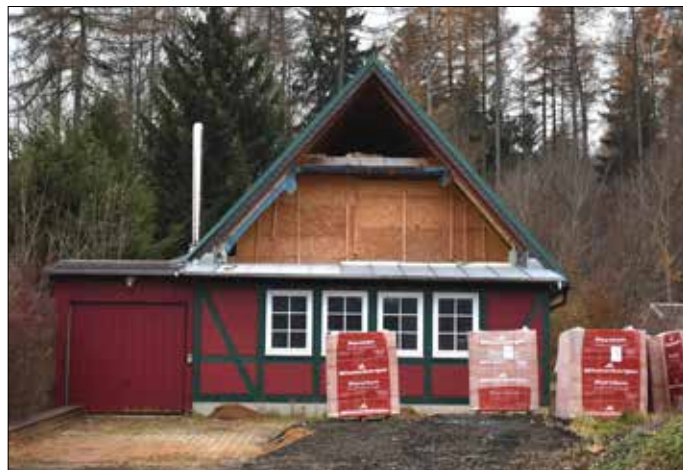
Noch nicht in die Jahre gekommen ist das Gebäude in der Liststraße, es wird dennoch umgebaut
