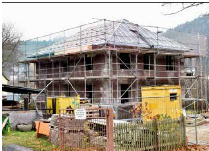
Zwischen der Almanka und dem Bauhof entsteht dieses Eigenheim
