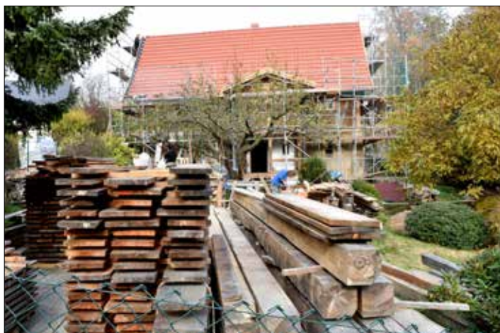
Im Eschengrundweg wird ein Umgebendehaus saniert
