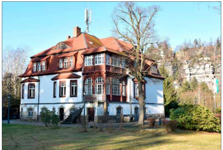
Sanierungsbedürftig und kaum nutzbar für die Gemeinde ist das Rathaus in der Freiligrathstraße.
