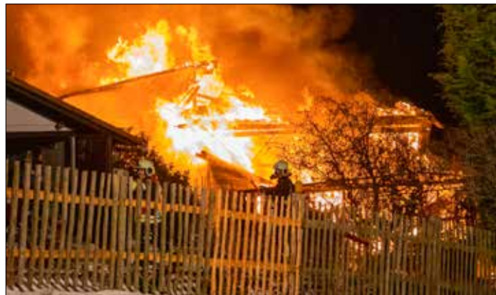
In der Nacht vom 6. zum 7. März konnten die Kameraden der Freiwilligen Feuerwehren nur den Schaden begrenzen, der durch den Brand eines Wohnhauses auf dem Lückendorfer Sommerberg entstand. Foto Feuerwehr
