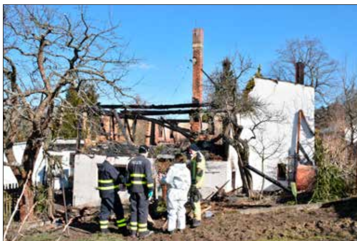
Spezialkräfte der Polizei suchten nach der Brandursache und möglichen Überresten der beiden Bewohner.
