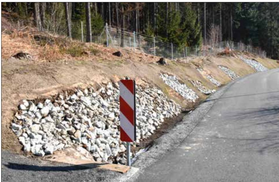
Mehrere Rutschungen an der Böschung wurden beseitigt.
