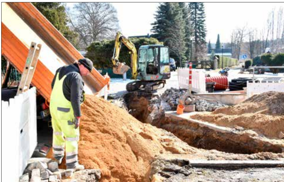
Mitarbeiter der Rohrleitungs- und Tiefbau GmbH aus Zittau führen die Arbeiten aus.
