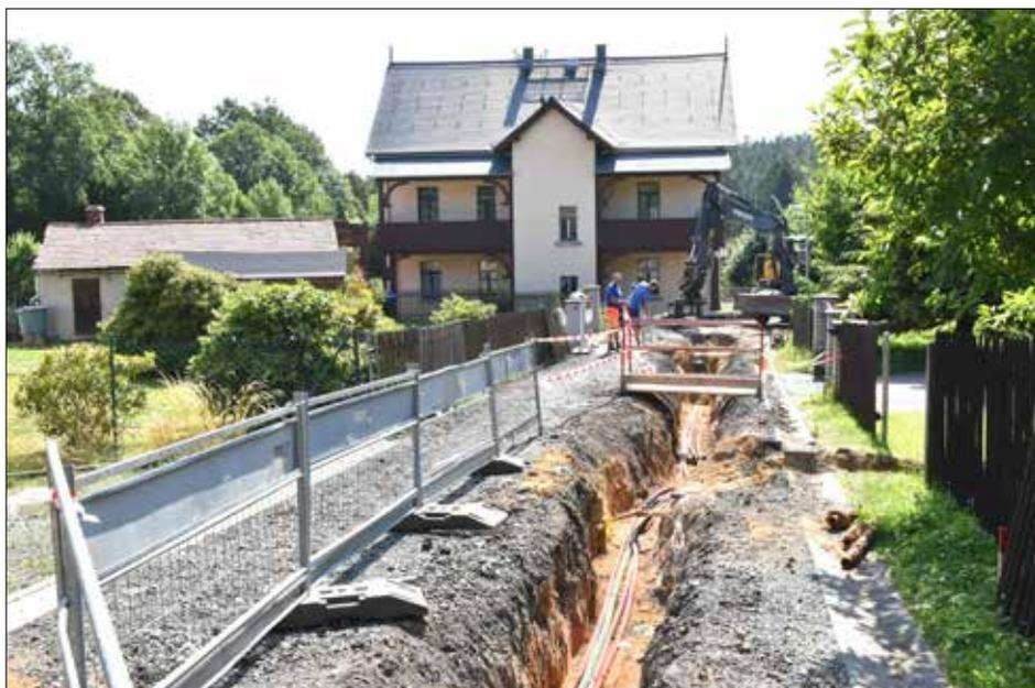
In Richtung Friedrich-Engels-Straße erfolgte die Verlegung der Rohre für das Breitbandkabel
