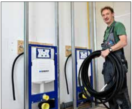
Hagen Münch von der Firma Clausnitzer be- gann Ende Juni mit der Installation der Sani- täranlagen
