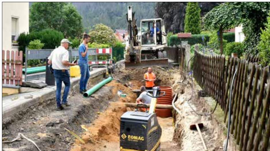
In Höhe der Hausnummer 9 waren bereits die Medien verlegt
