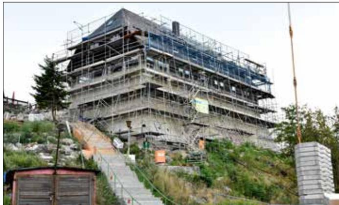
An der Hochwaldbaude sind die Dachdecker am Werk, darüber hinaus wird die Schindelverkleidung an den Außenwänden ersetzt
