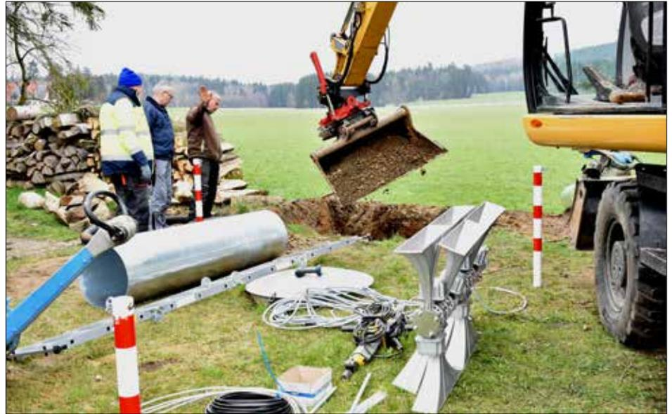
Der dafür benötigte ca. 18 Meter hohe Mast konnte daraufhin aufgestellt und die Sirenenanlage montiert werden. Bei Alarm wird diese einen Ton in einer Lautstärke von ca. 115 Dezibel (dB) die Lückendorfer Kameraden alarmieren.
