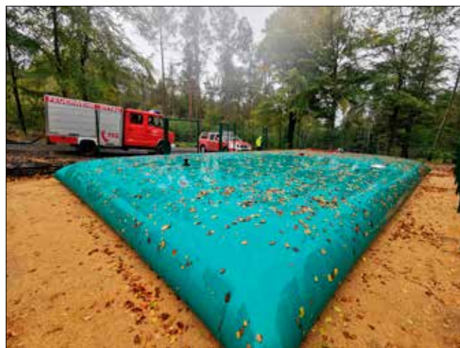
Unterhalb der Töpferbaude wurde der Löschwasserbehälter gefüllt. Die Kosten werden mit ca. 45.000 Euro beziffert, dies ohne Fördermittel von der Stadt Zittau.
