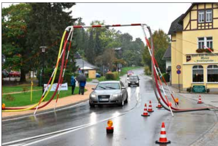
Eine „Schlauchbrücke“ gehörte mit zur Logistik um vom Goldbach das Wasser auf den Töpfer pumpen zu können
