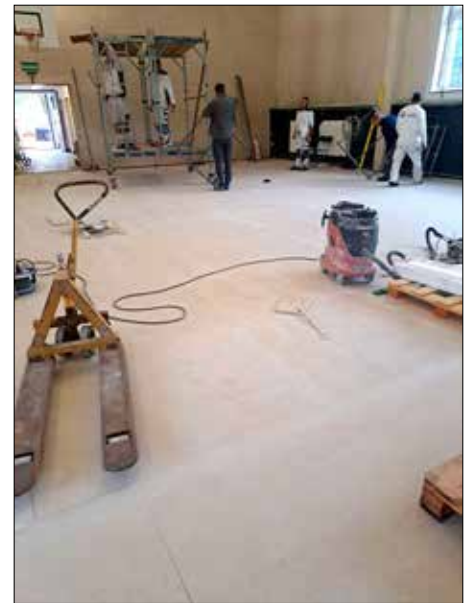
Bevor der neue Belag verlegt werden konnte, galt es Dämmplatten zu verlegen, Fotos T. Steiner
