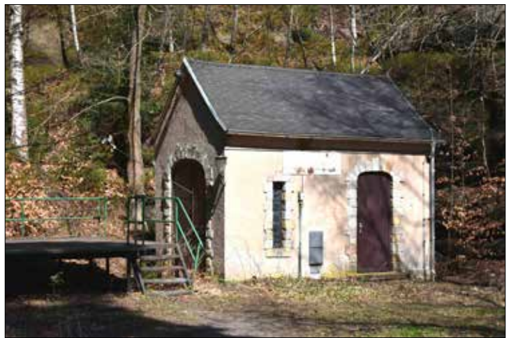
Am Ausgang des Hausgrundes befindet sich die Talstation des ehemaligen um 1960 gebauten und jetzt still gelegten Lastenaufzuges
