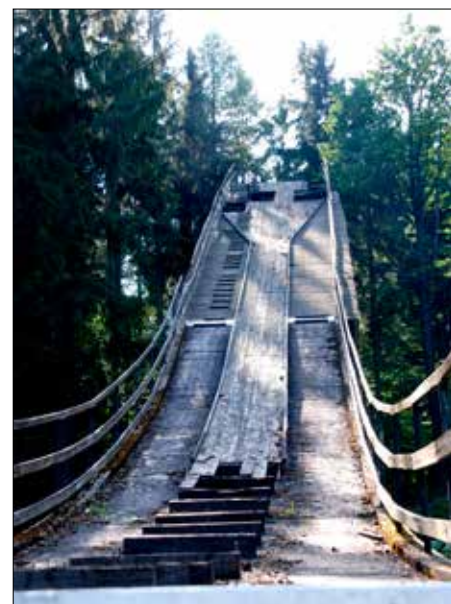
Die Holzkonstruktion der Sprungschanze be-durfte steter Reparaturen
