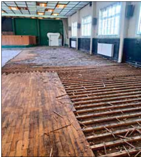
Im September vergangenen Jahres begannen die Reparaturarbeiten am Fußboden. Foto T. Steiner
