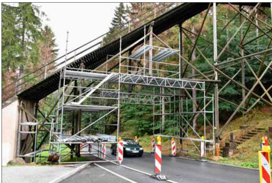
Die letzte Reparatur der denkmalgeschützten Schanze fand im Jahr 2019 statt
