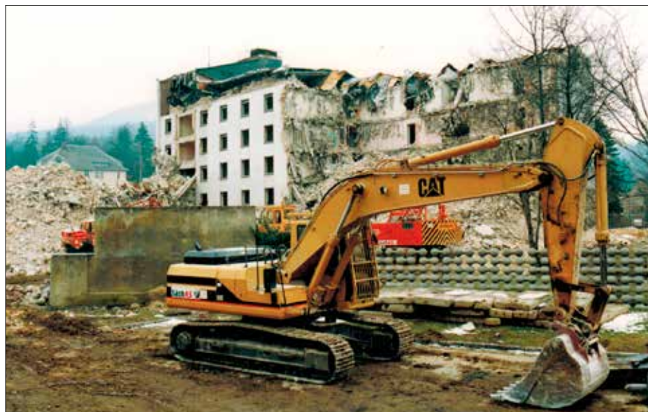
Die Abrissbirne leistete ganze Arbeit
