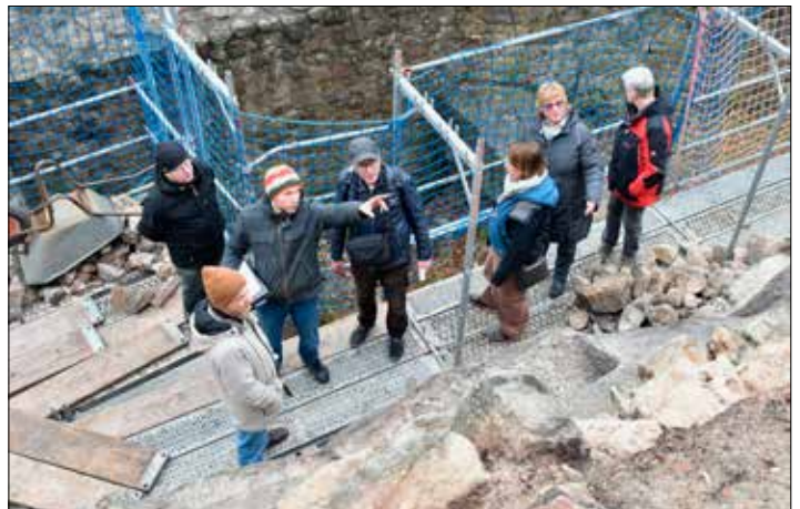
Das bislang verborgene und jetzt freigelegte Mauerwerk oberhalb des unteren Burgtores wird weiterhin gesichert
