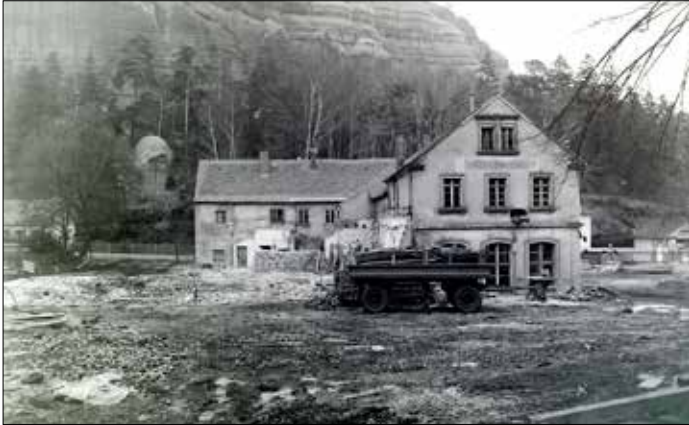
Der Abriss begann vor 40 Jahren
