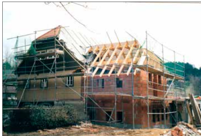
Das Richtfest für den geplanten Kindergarten wurde am 09. April 1999 feierlich begangen
