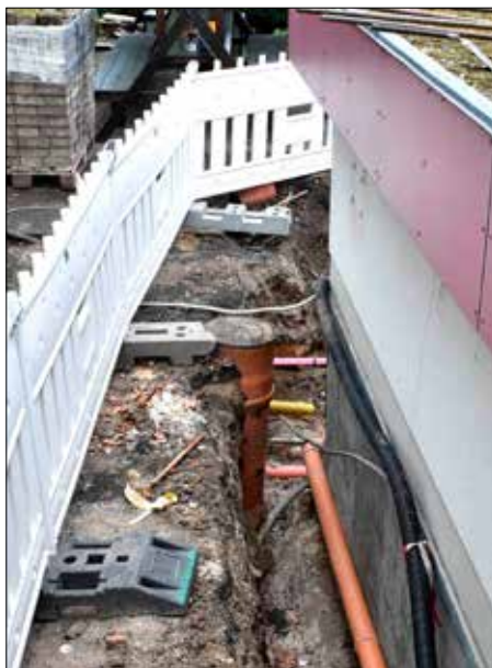
Bis in Richtung Kammstraße wurde Drainage verlegt
